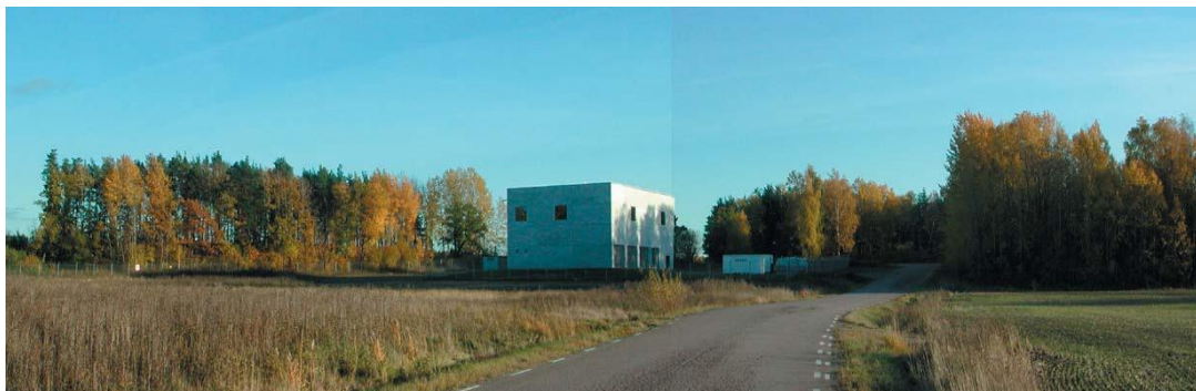
Befintlig reningsanläggning, vy från norr (foto: Andersson & Jönsson Landskapsarkitekter AB)
