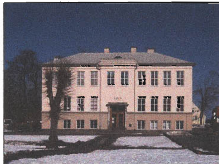
Foto: Fasad mot skolgården i sydväst. Mars 2010
